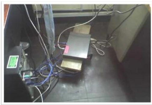
Figura 11. Fotografía diagnóstica de la situación previa en el área a intervenir
